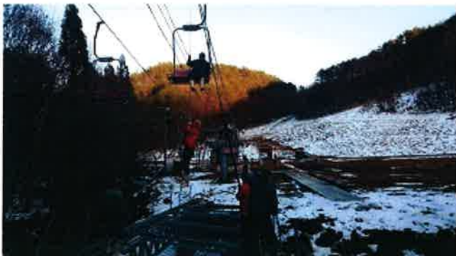
「おーひら第1リフト 3号支柱付近」
